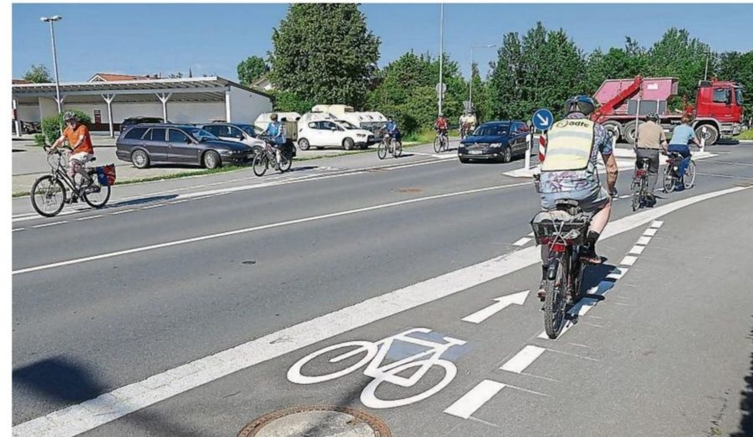
Einschleifspuren für Pedalritter: Vor dem neuen Kreisverkehr in der Holzkirchner Industriestraße bekamen die Radler Ein- und Ausfahrten von den Radwegen, um im Mischverkehr neben den Autos im Kreisel mitschwimmen zu können.
